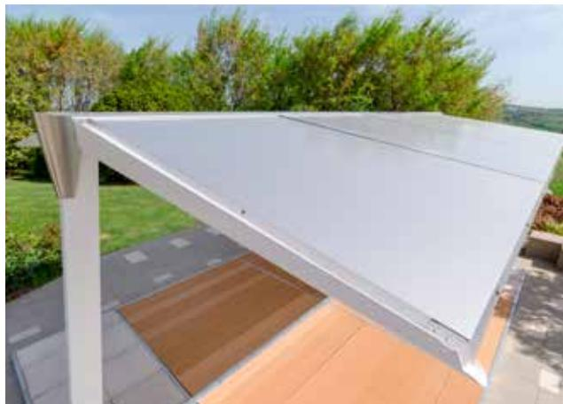
La copertura in alluminio stratificato con un'anima termoisolante permette di riflettere i raggi solari garantendo un ottimo comfort anche nelle giornate più assolate.
