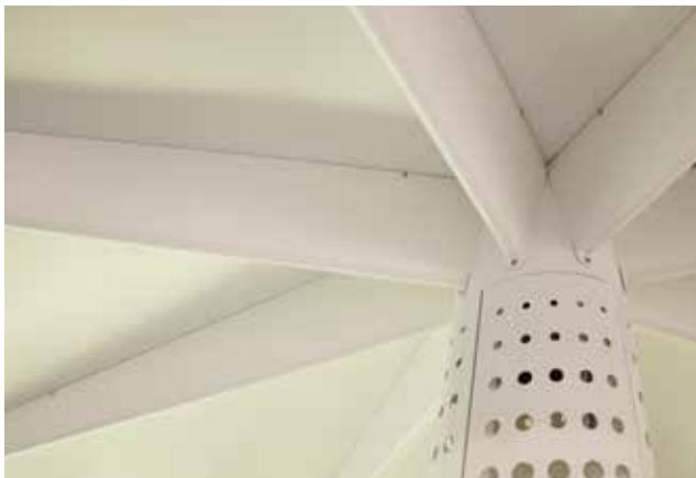
La struttura in acciaio, trattata con cataforesi, sorregge la copertura in alluminio stratificato che ha caratteristiche di riflettenza termica, permettendo di irradiare il calore emanato dalla fiamma e garantire un elevato risparmio energetico dovuto al recupero del calore prodotto.
