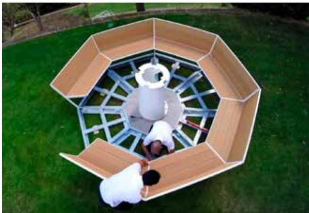
Il progetto strutturale, basato sul bilanciamento tra pedana e copertura, rende il sistema riscaldante outdoor completamente autoportante, e la sua semplice installazione non necessita di autorizzazioni edilizie.
